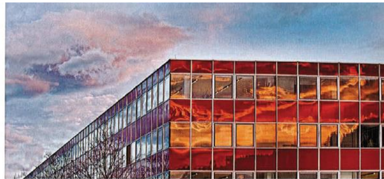
Das ARZ, im Bild das Rechenzentrum in der Anton-Melzer-Straße in Innsbruck, hat sich auf die Entwicklung von Kernbankensystemen und Rechenzentrumsdienstleistungen im Bankenbereich spezialisiert.
